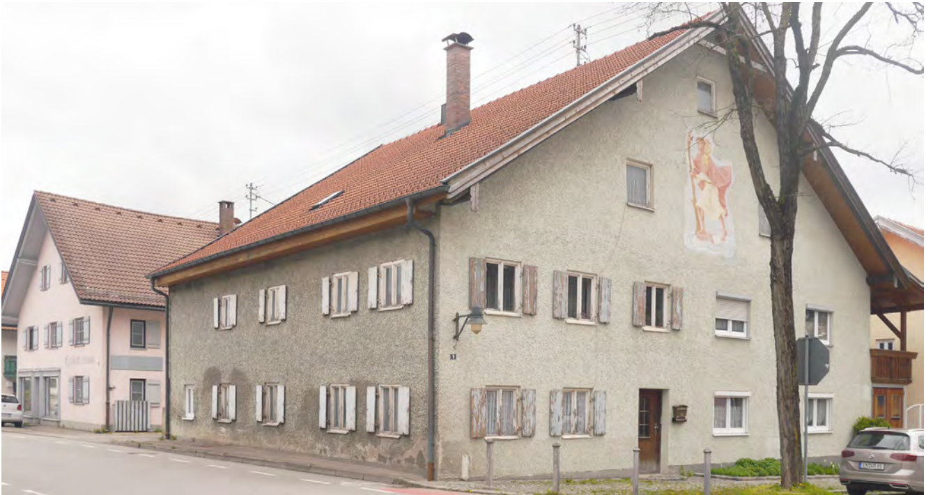
Abb. 31: Leerstehende Gebäude im Ortskern | Obere Straße
