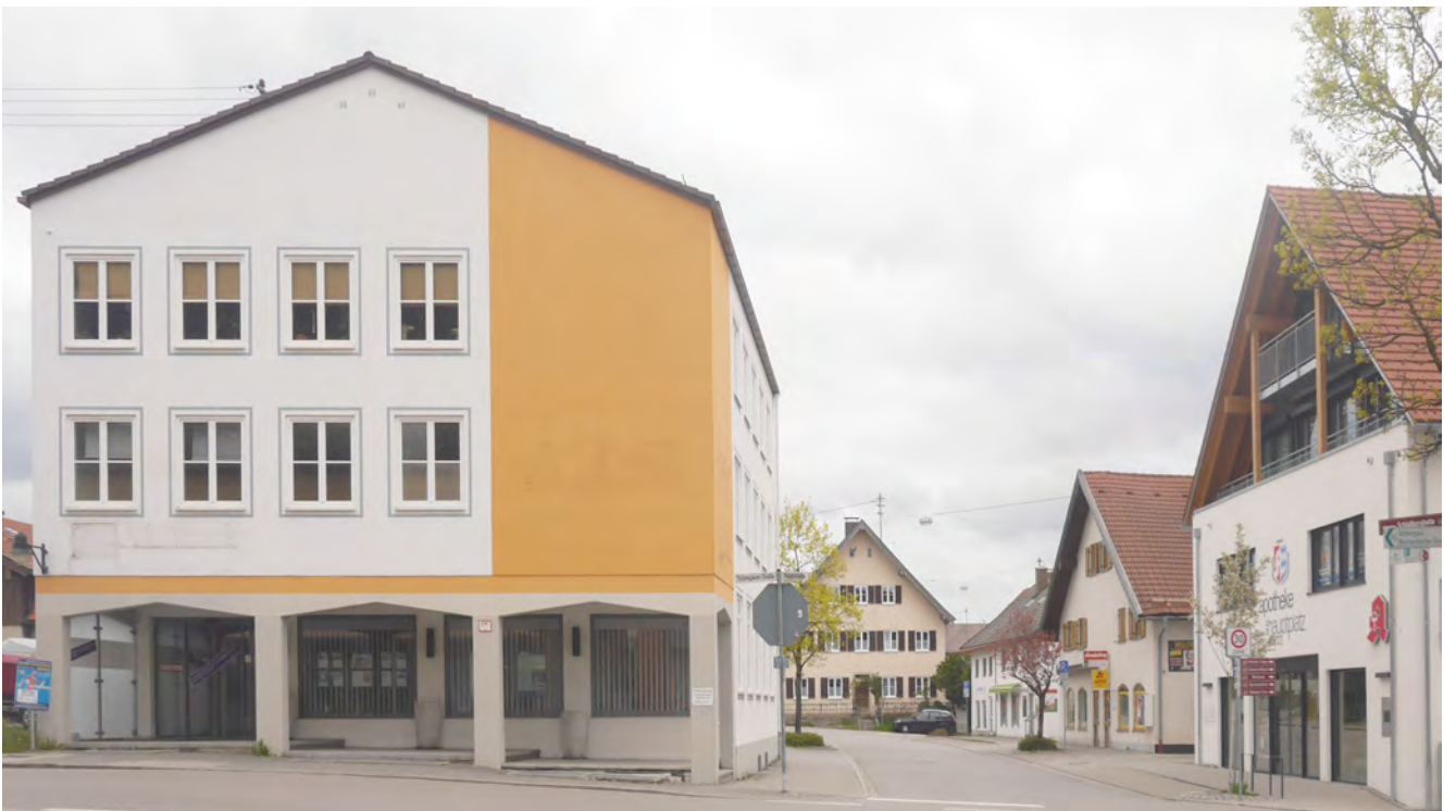
Abb. 32: Gebäude mit moderner Formensprache integrieren sich in das Ortsbild | Schongauer- Ecke Müllerstraße
